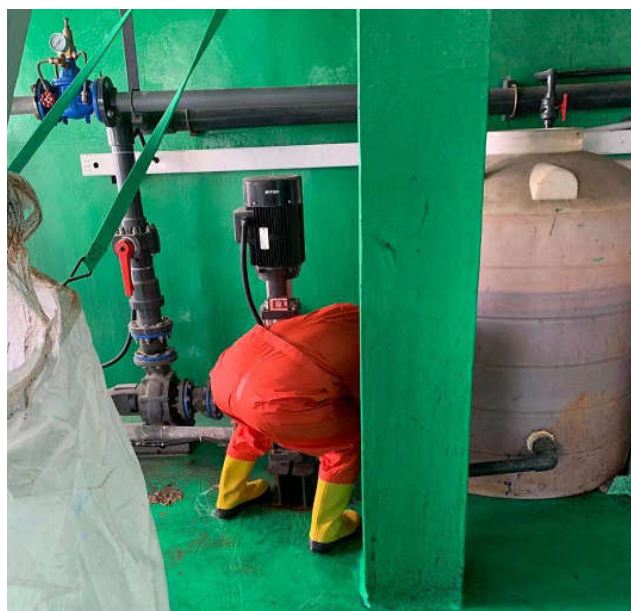
进入现场排查泄露点，关闭泄露管道阀门，阻止进一步的泄露
